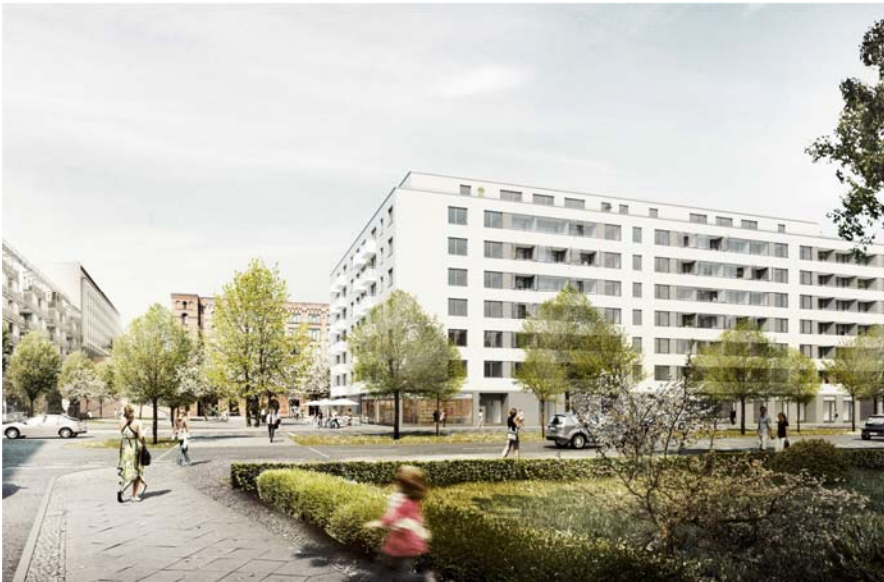
Ansicht des Neubaus (rechts) von der Friedenstraße aus © DMSW
