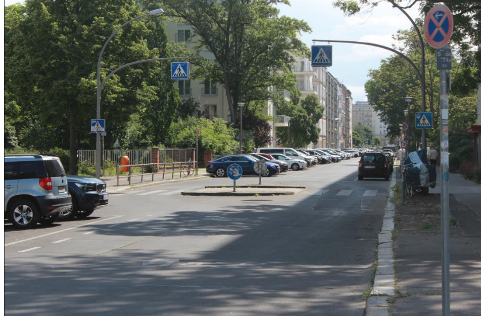
Abbildung 17: Palisadenstraße Blickrichtung Osten
