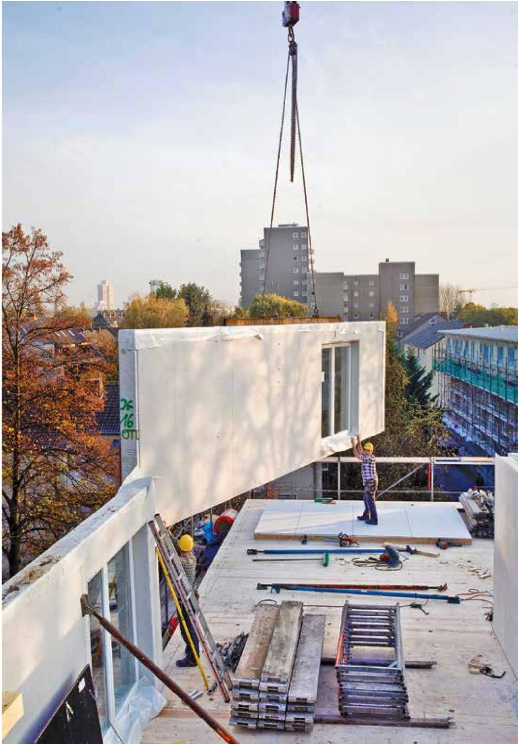
Montage der fertigen Fassadenelemente, Aufstockung
