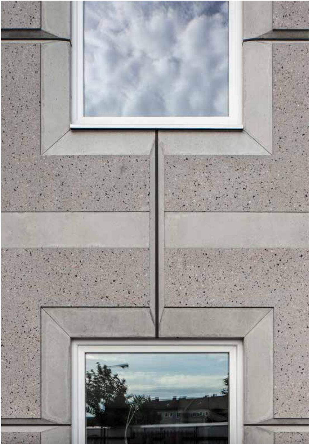
Studentenwohnheim SilbermannPark: Gliederung der Fassade durch Wechsel von glatter und rauer Betonoberfläche sowie Fugen in Fenstermitte
