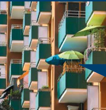
In der Südekumzeile in Spandau konnte die komplexe Sanierung von 648 Wohneinheiten in sieben Wohnhäusern abgeschlossen werden. In insgesamt 6 Jahren wurden Dächer erneuert, Fassaden gedämmt, Fenster und Balkontüren erneuert, alle Balkone saniert, Treppenhäuser instandgesetzt sowie Bäder und Küchen modernisiert. So konnte die Wohnqualität gesteigert und gleichzeitig die Energieeffizienz um 50 Prozent verbessert werden.
