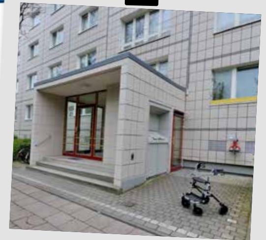
Verlängerung Aufzüge für barrierefreien Zugang in der Karl-Marx-Allee, Mitte
