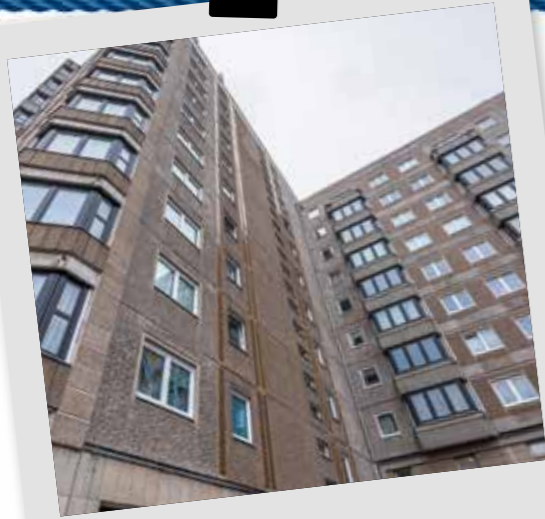
Einbau von Schallschutzfenstern für 480 Wohnungen, hier Köpenicker Straße, Mitte
