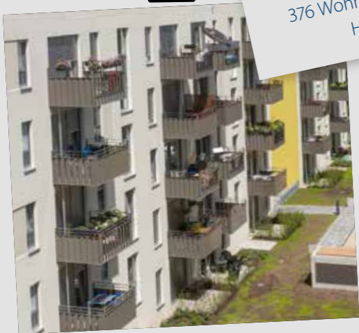
Fertigstellung von 128 Wohnungen im Quartier Schmid, Mitte
