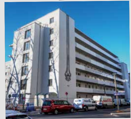
Neubau Strausberger Straße 38, Berlin-Friedrichshain, 50 Wohnungen, Fertigstellung März 2018
