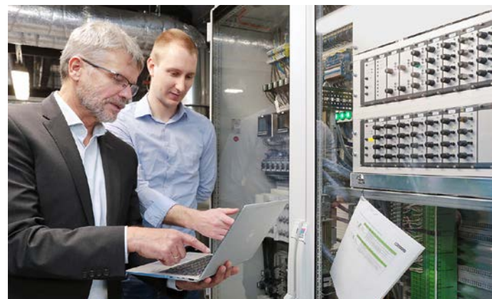
Im Projekt BaltBest erforschen wir die optimale Betriebsführung von Heizungsanlagen.
